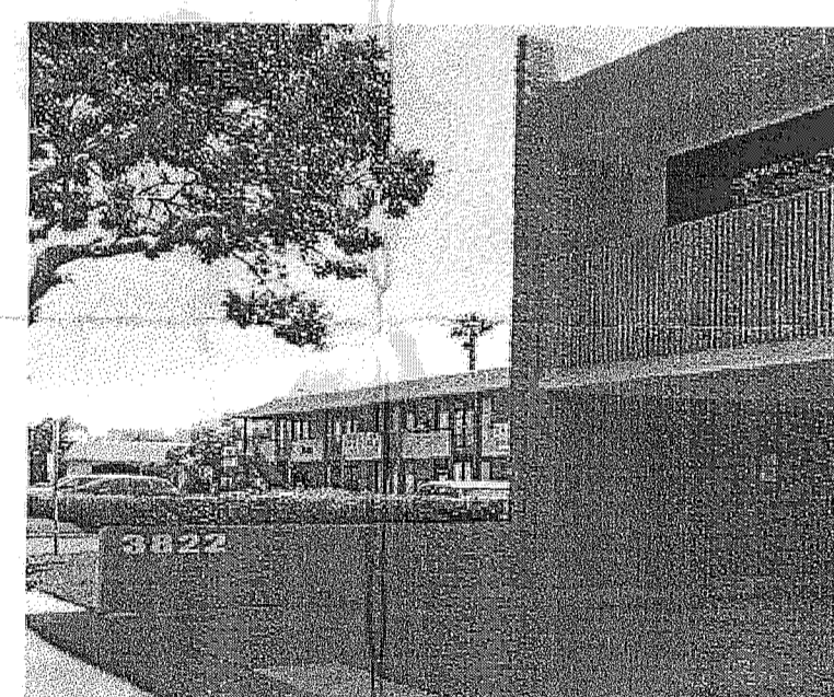
EXISTING WALL (BEFORE)
